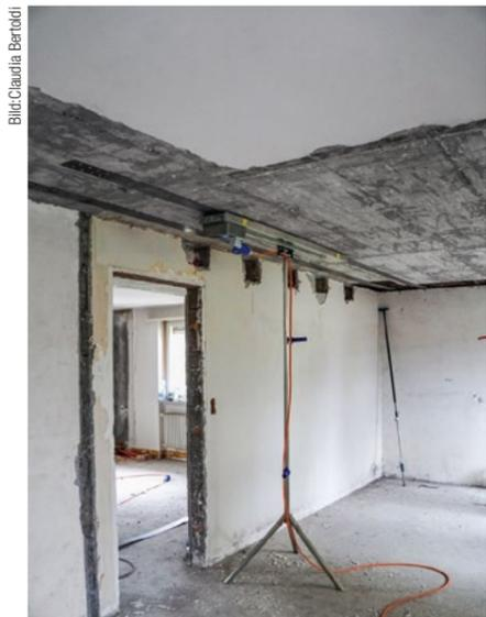
Die ersten zwei Lamellen werden parallel zur Mauer befestigt und mittels Erhitzen gespannt.
