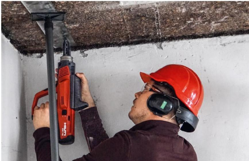
Danach müssen die Enden mit Metallnägeln an der Decke fixiert werden. Zuerst werden in der Decke mithilfe der fabrikseitig vorgesehenen Bohröffnungen der Lamellen die Punkte markiert.
