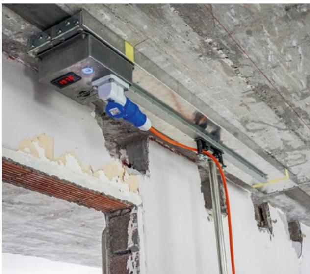
Eine Temperaturanzeige ermöglicht die Überwachung des Heizvorgangs auf über 160 Grad Celsius.
