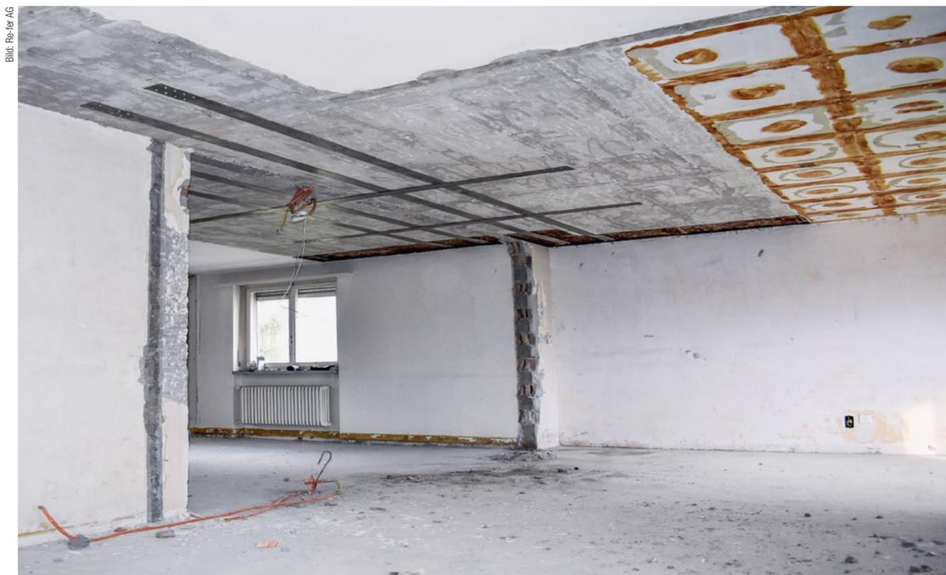
Nach der fertigen Bauwerksverstärkung an der Geschosdecke kann die Mauer ausgebrochen werden. Erhalten bleiben nur schmale seitliche Säulen. Die Lamellen sind nur 1,5 Millimeter dick. Nach dem Auftrag des Deckenputzes sind sie nicht mehr sichtbar, das Raumvolumen verringert sich minimalst.
