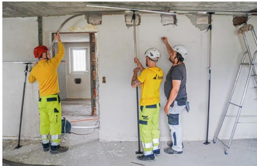
Die Metallbänder werden anschliessend mit mehreren Teleskopstützen an der Decke fixiert. Zwei Mitarbeiter der Firma Hodel werden eingewiesen.
