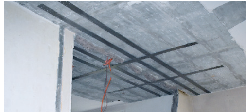
Externe Verstärkungsmassnahme: re-plate endverankert mit Hilti Direktbefestigung
