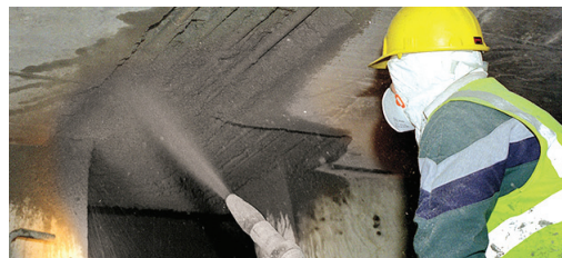
Überkopf/Vertikal im Spritzmörtel: re-bar in Sika MonoTop-422 PCC
