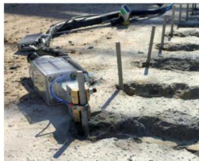
Instandsetzung des Kurtheaters Baden. Links: Anbringen der re-bar-Schubbügel. Rechts: Aktivieren der Schubbügel mittels Aufheizen (planendes Ingenieurbüro: WaltGalmarini, Zürich; ausführende Unternehmung: SikaBau, Aarau).
