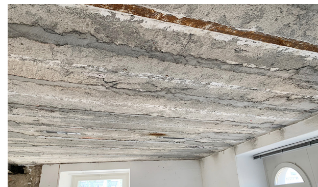
6. Onderzijde plafond aanzicht na Versterking
