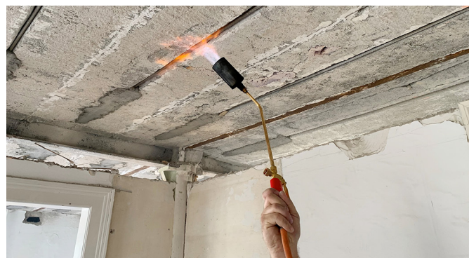
5. Activeren van de re-bar met behulp van gasbrander, over de vrije lengte
