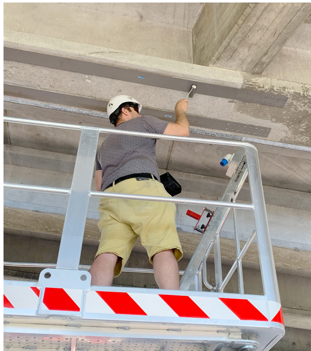
4. Het opnieuw coaten met Sikaflex® PRO-3 op de bouwplaats
