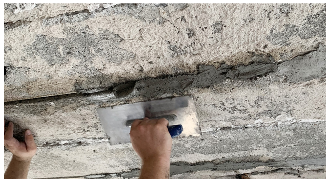
3. Aanbrengen Sika MonoTop®-412 Eco
