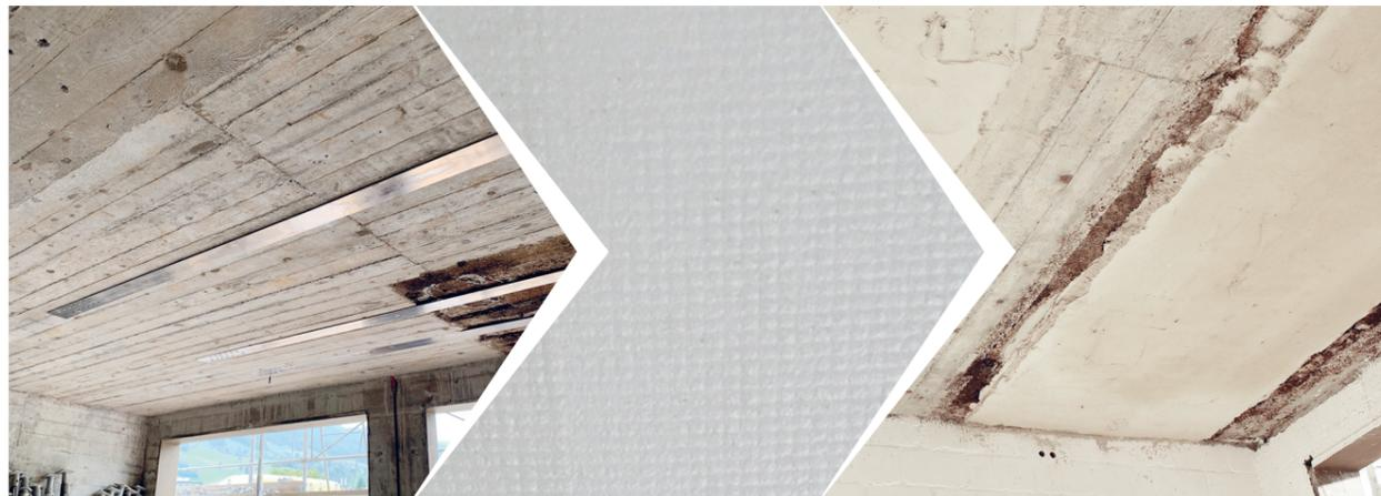
1. re-plate aktiviert 2. Glasnetz im SikaCem Pyrocoat Base® 3. Brandschutzschicht SikaCem Pyrocoat®
