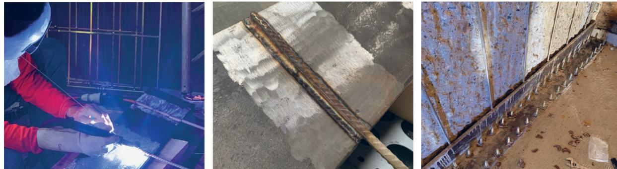
Da es sich bei memory-steel um einen hochlegierten Edelstahl handelt, ist für Schweissarbeiten ein ausgebildeter Edelstahlschweisser beizuziehen. Bei der Wandverstärkung in Mellingen wurde das Wolfram-Inertgas-Schweissen mit einem 1.6 mm Draht «Böhler A7 CN-IG» als Schweissgut eingesetzt.
