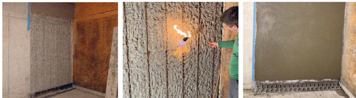
Das Verstärkungssystem eignet sich auch gut zur nachträglichen Erdbebenertüchtigung, um horizontale Kräfte abzutragen oder vertikale Zugkräfte zu überdrücken. Das Zusammenschweissen von re-bar mit Verankerungsteilen aus Stahl bietet am Objekt einfache Lösungen zur Kraftübertragung der Vorspannkräfte in den Beton.
