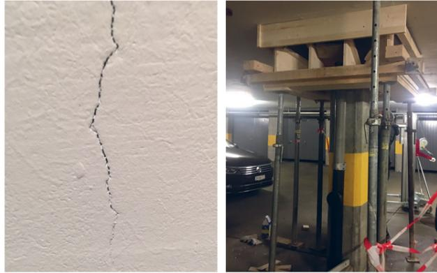
1. Risse an Deckenuntersicht 2. Neue Betonpilze
