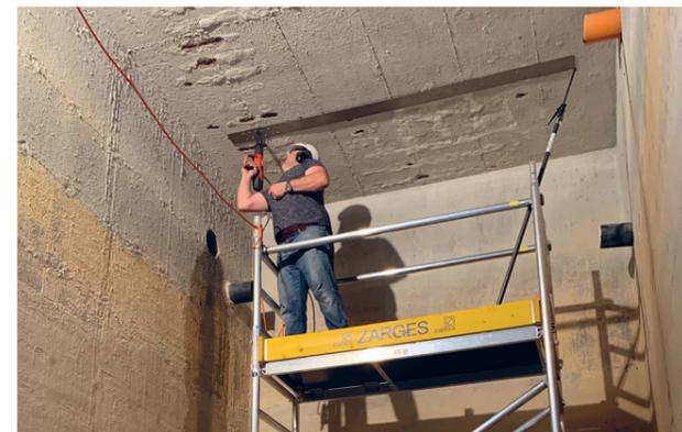
3. re-plate zwischen Schadstellen des Betons
