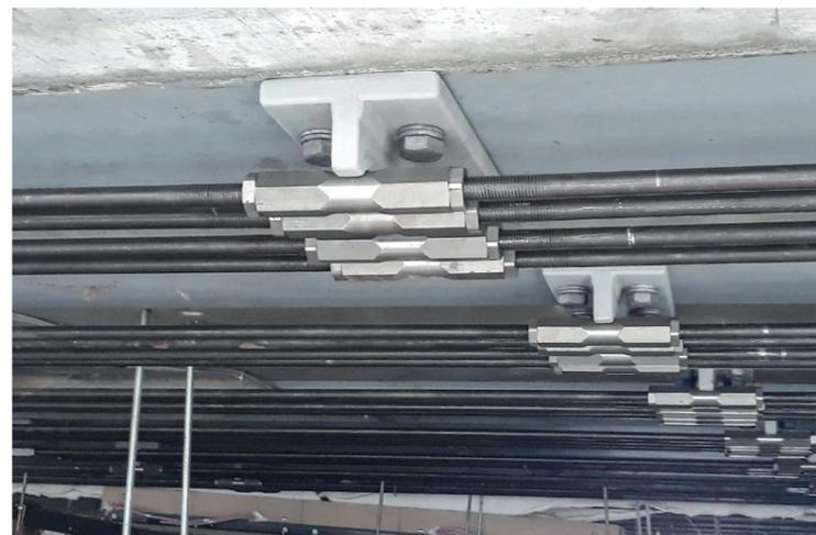
2. Verstärkung mit re-bar R18 parallel zum Stahlträger mit Auflager mittig vor Korrosionsschutz
