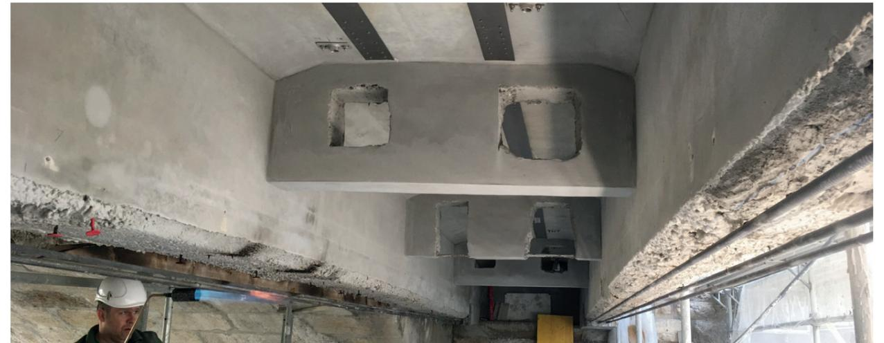
5. re-plate wurde unter Betonplatte, re-bar unter Betonbalken appliziert
