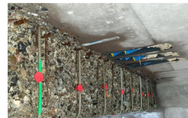
1. re-bar Schubbügel mit re-bolt Kunststoffdübeln fixiert
