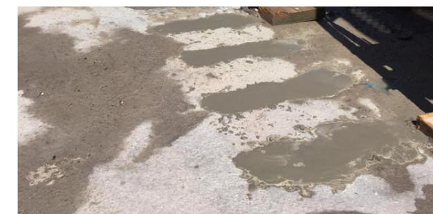
4. Schlitze mit eingebogenen re-bar Schubbügel gefüllt
