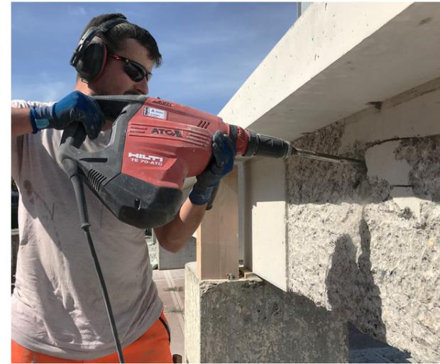
5. Mechanische Abtragung mit Abbauhammer
