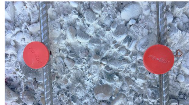
7. Fixieren der re-fer Schubbügel mit re-bolt
