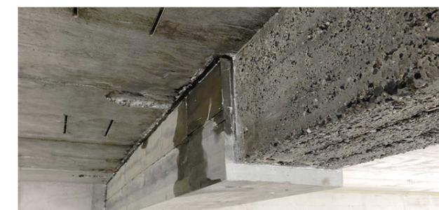
2. Beidseitig verstärkter Bereich mit SikaGrout-314 Fließmörtel
