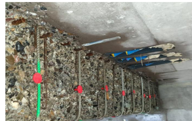
1. re-bar étriers fixés avec chevilles re-bolt
