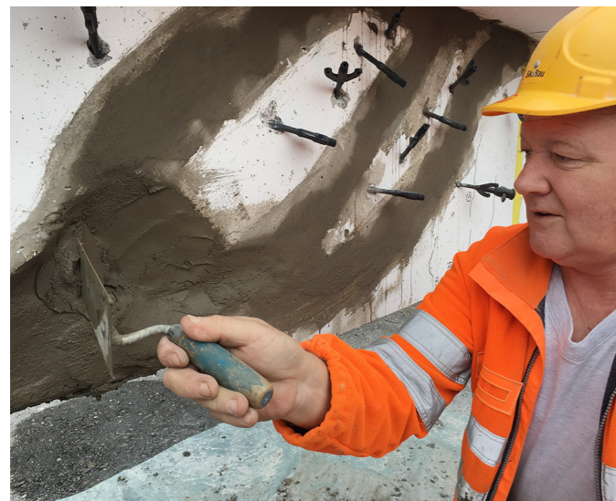
3. Fermeture superficielle des fissures avec Sika FastFix-121
