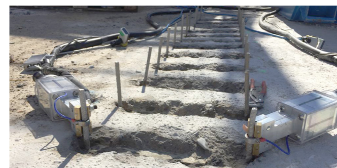
3. Activation par chauffage électrique
