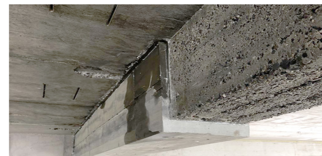
2. Sections renforcées des deux côtés avec mortier SikaGrout-314
