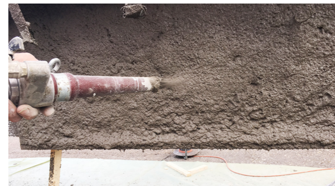
9. Mortier projeté Sika MonoTop -412 N
