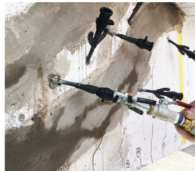
4. Injection avec Sika InjectoCem-190 A+B
