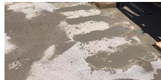
4. Rainures avec étriers repliés remplies de mortier
