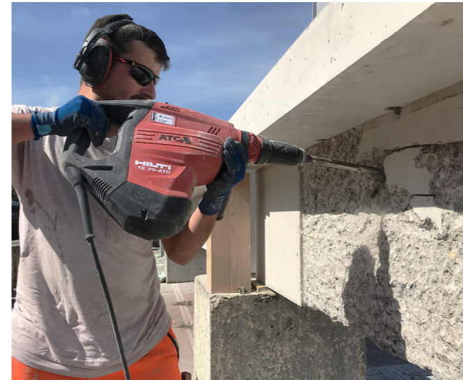
5. Surface rugueuse par marteau-piqueur
