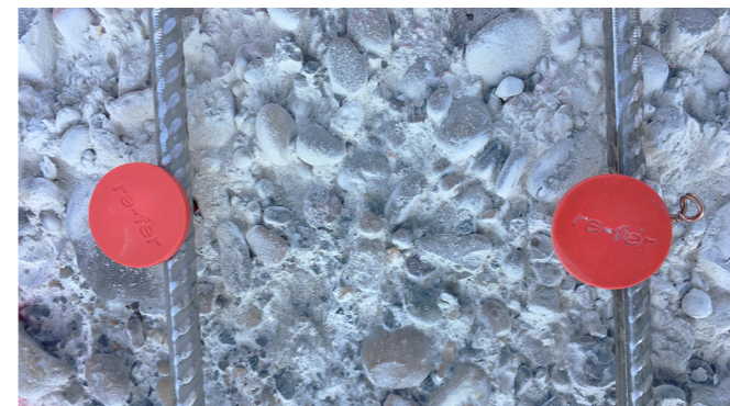
7. Fixation des étriers re-bar avec re-bolt
