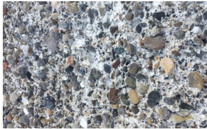
1 Hydromechanisches Aufrauen des Betontraggrundes
