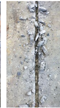
1 Einschlitzen der Betonnut im Betontraggrund (Breite 3.5 cm / Tiefe 2.5 cm / für re-bar Ø12 mm)
