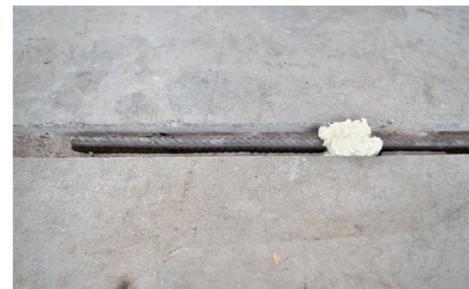
3 Beidseitiges Abschotten und Einbetten in SikaGrout-311
