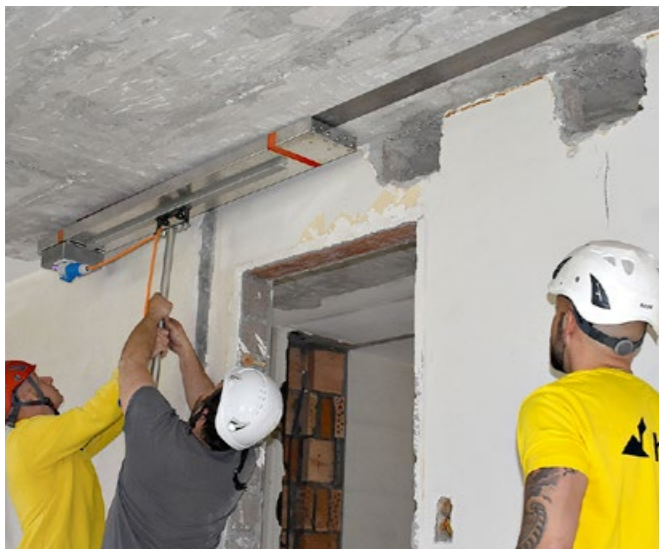
5 etappenweise Erwärmung mit re-IR 3000 Infrarot-Heizstrahler
