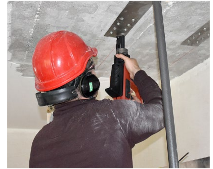
4 mechanisch endverankern mit Hilti Bolzensetzgerät und systemgeprüften, rostfreien Bolzen (X-CR 48 P8 S15)
