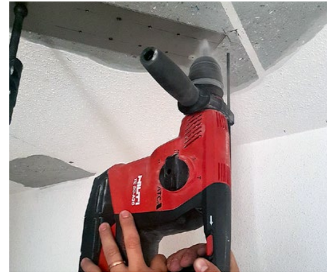
3 Traggrund durch vorgelochte re-plate vorbohren
