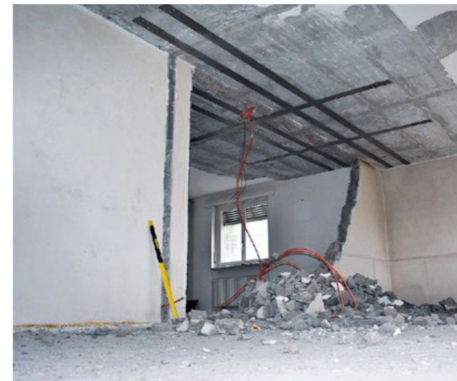
7 re-plate fertig appliziert und vorgespannt – tragende Bauteile können jetzt entfernt werden – falls erforderlich, systemgeprüftes Sika Brandschutzsystem applizieren
