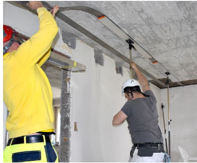
2 re-plate provisorisch mit T-Stützen fixieren
