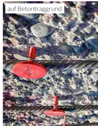
2 Fixieren von re-bar mit elektrischen Isolatoren re-clip und/oder re-bolt
