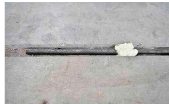
3 Beidseitiges Abschotten und Einbetten in SikaGrout-311
