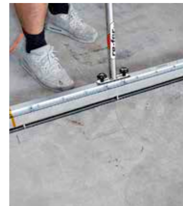
4 Aktivieren «Erhitzen» von re-bar mit Infrarot-Heizstrahler re-IR 1500
