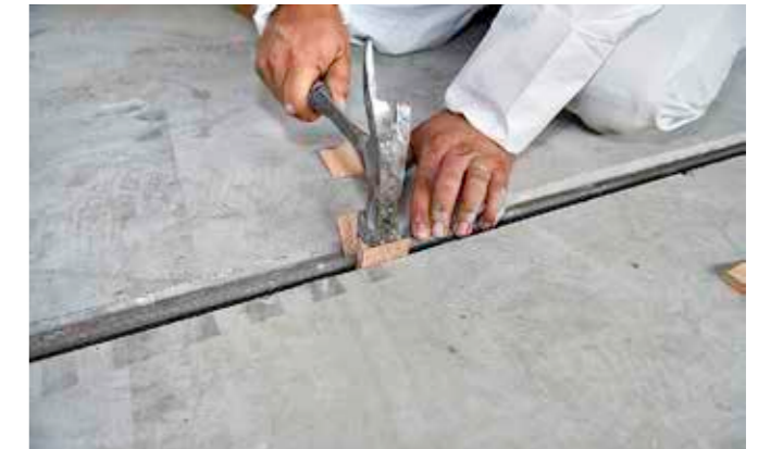
2 re-bar zentrisch in Betonnut fixieren
