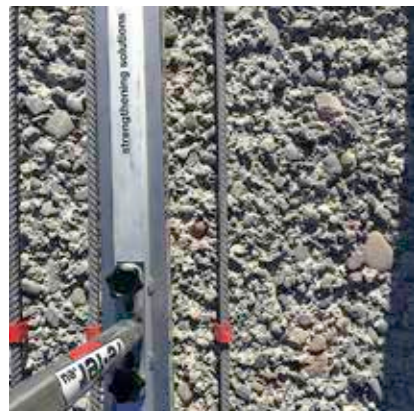
4 Aktivieren «Erhitzen» von re-bar mit Infrarot-Heizstrahler re-IR 1500
