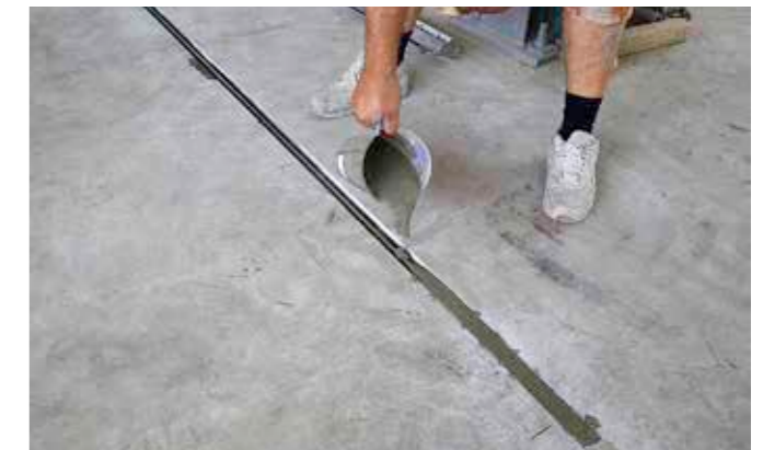
5 Vergießen von re-bar mit SikaGrout-311 zwischen den beidseitigen Endverankerungen
