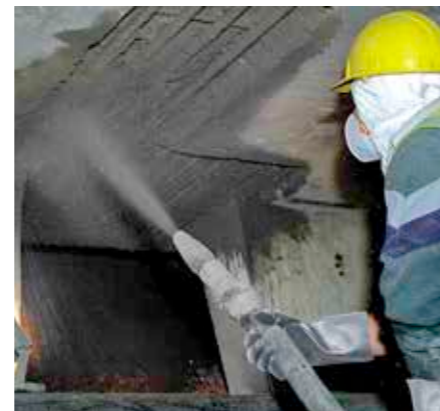
5B Sika MonoTop-422 PCC zwischen den Endverankerungen applizieren
