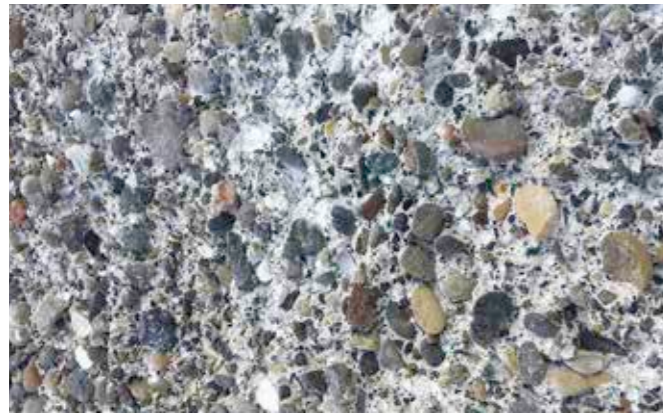
1 Hydromechanisches Aufrauen des Betontraggrundes
