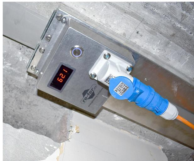
**6** Temperaturkontrolle beim Erhitzen über das eingebaute Steuergerät
