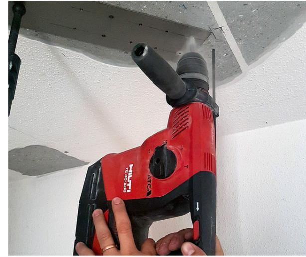
**3** Traggrund durch vorgelochte re-plate vorbohren Ø 3.5 mm
