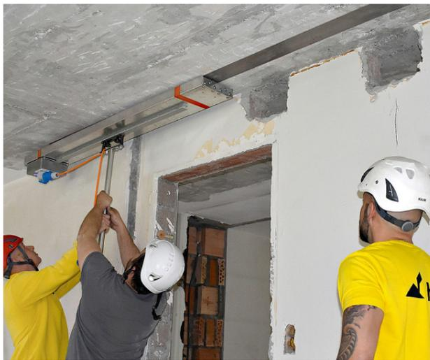
**5** etappenweise Erwärmung mit re-IR 3000 Infrarot-Heizstrahler
