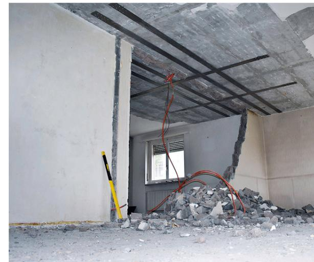
**7** Application et précontrainte terminée de re-plate – les éléments de construction porteurs peuvent maintenant être enlevés – au besoin, appliquer le système de protection ignifuge Sika testé pour le système
