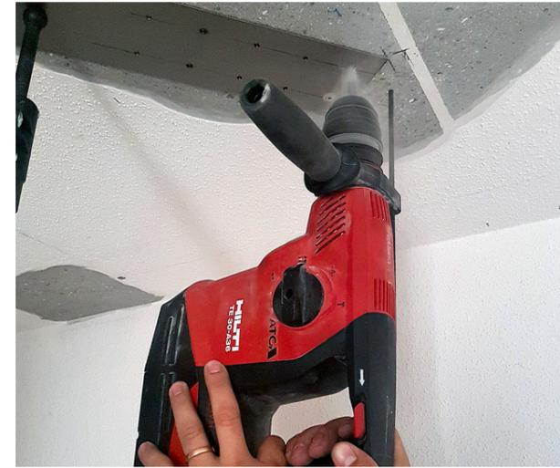
**3** Forer au préalable le support au travers des re-plate préalablement forées Ø 3.5 mm
