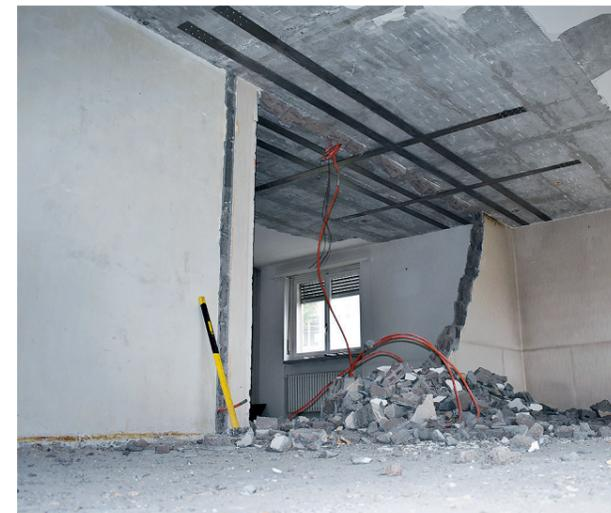
**7** Application et précontrainte terminée de re-plate – les éléments de construction porteurs peuvent maintenant être enlevés – au besoin, appliquer le système de protection ignifuge Sika testé pour le système
