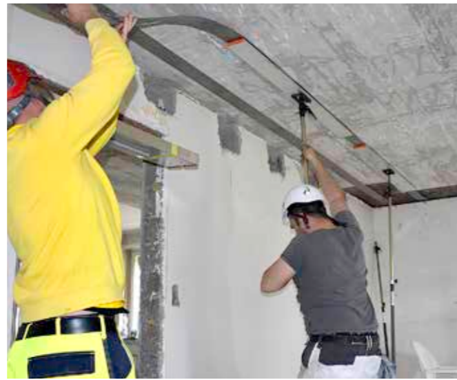
2 re-plate provisorisch mit T-Stützen fixieren
