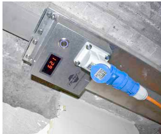
6 Temperaturkontrolle beim Erhitzen über das eingebaute Steuergerät Protokoll erstellen
