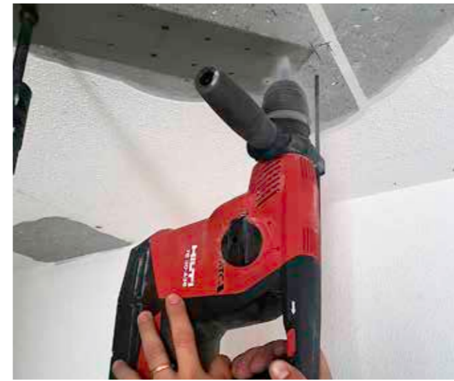
3 Traggrund durch vorgelochte re-plate vorbohren
