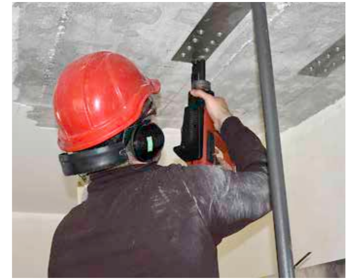
4 mechanisch endverankern mit Hilti Bolzensetzgerät und systemgeprüften, rostfreien Bolzen (X-CR 48 P8 S15)
