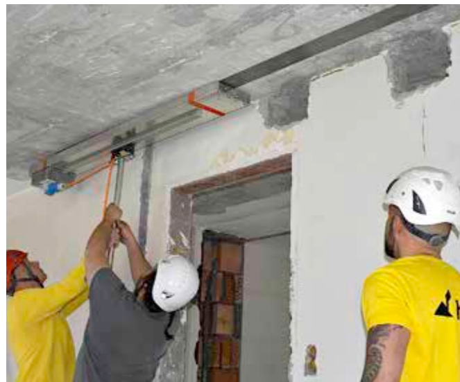
5 etappenweise Erwärmung mit re-IR 3000 Infrarot-Heizstrahler
