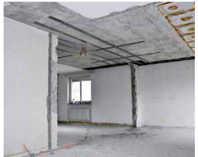
7 re-plate fertig appliziert und vorgespannt – tragende Bauteile können jetzt entfernt werden – falls erforderlich, systemgeprüftes Sika Brandschutzsystem applizieren
