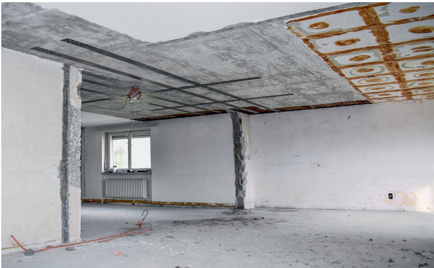
Nach der fertigen Bauwerksverstärkung an der Geschossdecke kann die Mauer ausgebrochen werden. Erhalten bleiben nur schmale seitliche Säulen. Die Lamellen sind nur 1,5 Millimeter dick. Nach dem Auftrag des Deckenputzes sind sie nicht mehr sichtbar, das Raumvolumen verringert sich minimalst.
