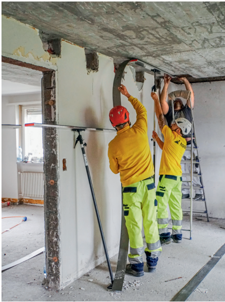
Die vorgesehene Position der «memory-steel»-Lamellen wird ausgemessen.
