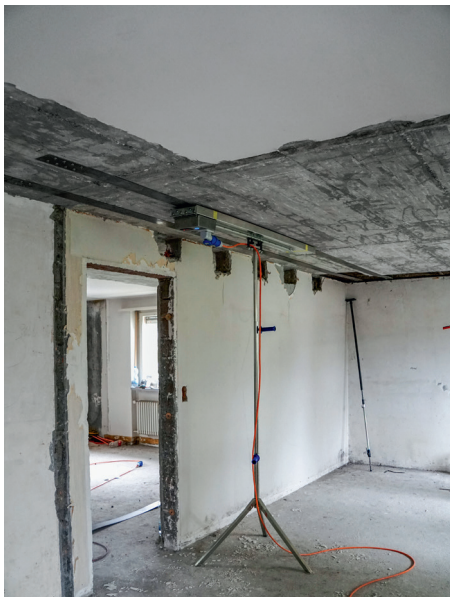
Die ersten zwei Lamellen werden parallel zur Mauer befestigt und mittels Erhitzen gespannt.
