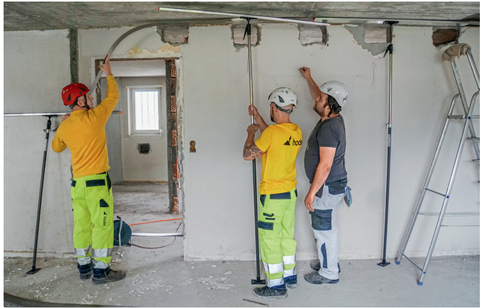
Die Metallbänder werden anschliessend mit mehreren Teleskopstützen an der Decke fixiert. Zwei Mitarbeiter der Firma Hodel werden angewiesen.
