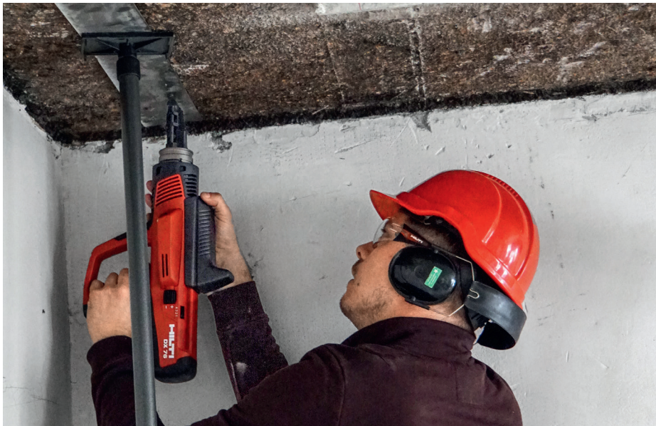
Danach müssen die Enden mit Metalnägeln an der Decke fixiert werden. Zuerst werden in der Decke mithilfe der fabrikseitig vorgesehenen Bohröffnungen der Lamellen die Punkte markiert.
