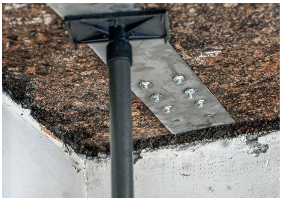
Die «memory-steel»-Lamellen haben bereits werkseitig gefertigte Bohrungen. Nach dem Vorbohren der Decke werden die Lamellen mit Stahlnägeln befestigt.
