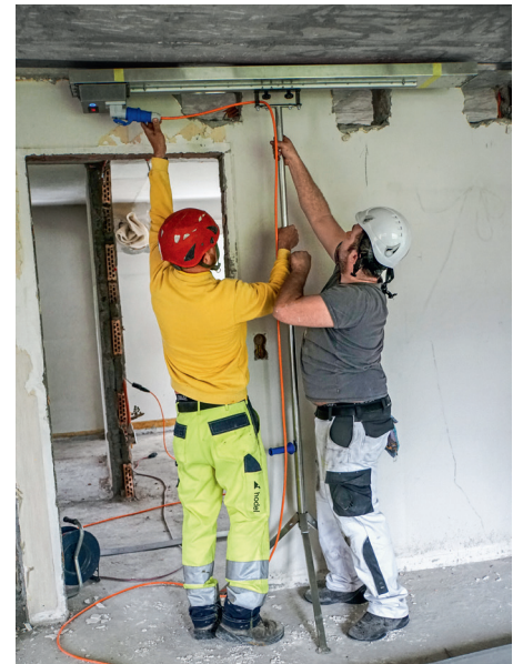
Die Infrarot-Heizstrahler für die Erhitzung der Lamellen werden angebracht.
