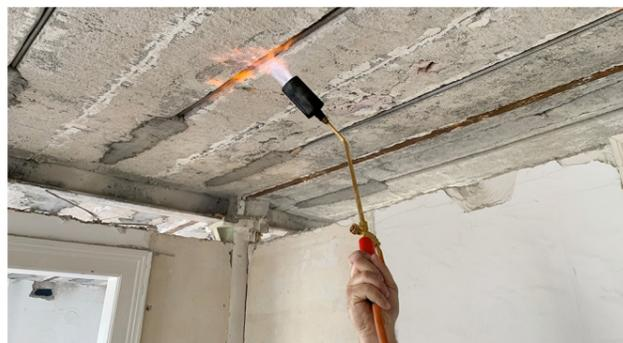
5. Aktivieren re-bar mit Gasbrenner über die freie Länge
