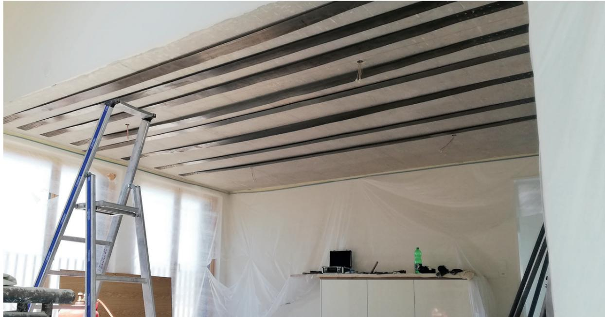
1. Deckenverstärkung zur Rissreduktion
