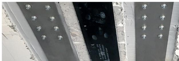
4. CFK-Lamellen Sika CarboDur® in Kombination mit re-plate
