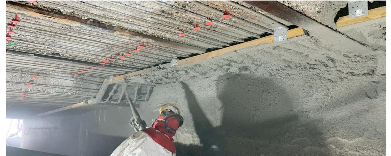
7. Beidseitige Endverankerung von 500 mm der re-bar Stäbe mit Sika MonoTop® 422 PCC Nassspritzmörtel
