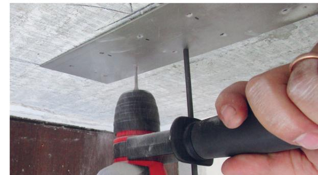
2. Vorbohren / Direktbefestigung mit Hiltisystem
