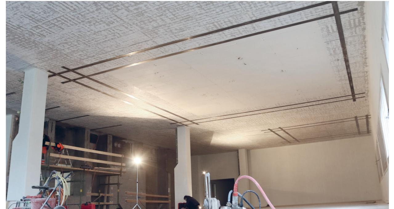
1. re-plate als Biegezugverstärkung einer Stahlbetondecke
