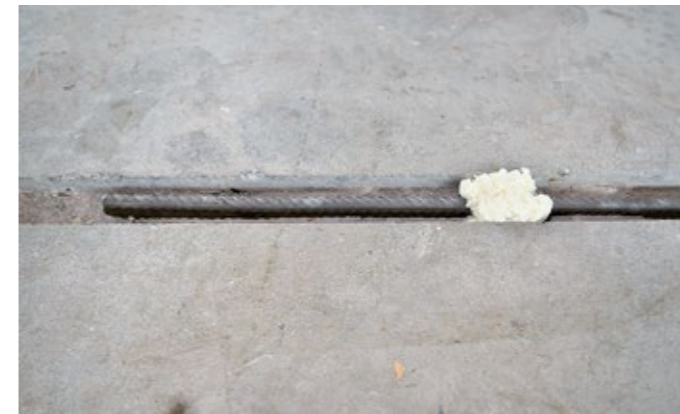
3 Beidseitiges Abschotten und Einbetten in SikaGrout-311
