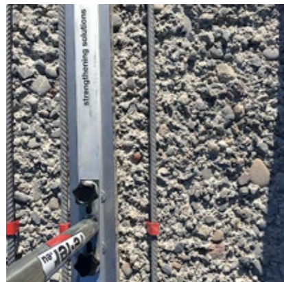
4 Aktivieren «Erhitzen» von re-bar mit Infrarot-Heizstrahler re-IR 1500
