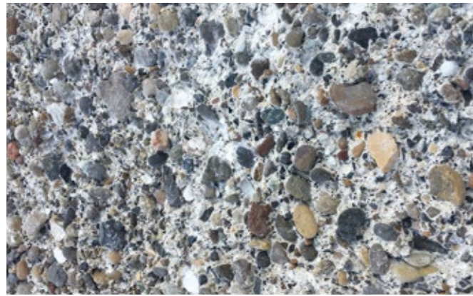
1 Hydromechanisches Aufrauen des Betontraggrundes
