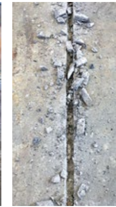
1 Einschlitzen der Betonnut im Betontraggrund (Breite 3.5 cm / Tiefe 2.5 cm / für re-bar \varnothing 12 \text{ mm} )
