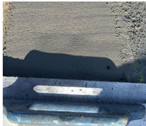
3A Beidseitiges Einbetten in Sika MonoTop-452 N «Reprofilermörtel» als Endverankerung
