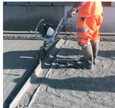
5A Sika MonoTop-452 N zwischen den Endverankerungen applizieren
