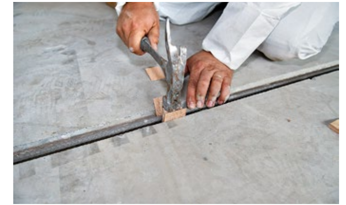
2 re-bar zentrisch in Betonnut fixieren
