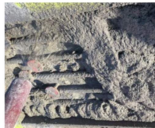
3B Enrobage sur les deux côtés dans le Sika MonoTop-422 PCC «mortier projeté» comme ancrage d'extrémité
