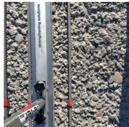
4 Activation de re-bar au moyen du chauffage infrarouge re-IR 1500
