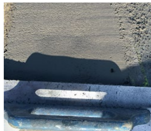
3A Enrobage sur les deux côtés dans le Sika MonoTop-452 N «mortier de reprofilage» comme ancrage d'extrémité
