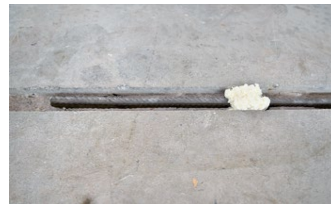
3 Cloisonnage et enrobage sur les deux côtés dans le SikaGrout-311
