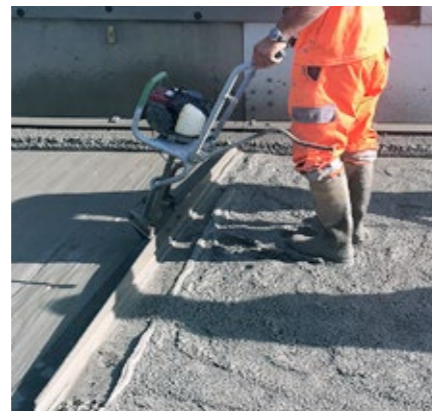
5A Appliquer Sika MonoTop-452 N entre les extrémités d'ancrage
