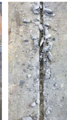
1 Fraisage de la rainure en béton dans le support (largeur 3.5 cm / profondeur 2.5 cm / pour les re-bar Ø12 mm)
