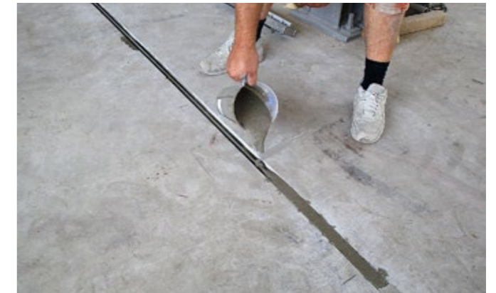
5 Aanbrengen van SikaGrout-311 rondom de re-bar, tussen de eindbevestigingen.
