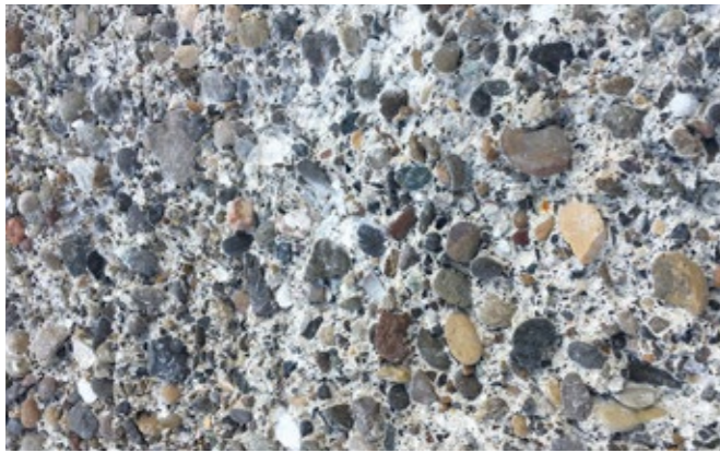
1 Hydromechanisch opruwen van de beton ondergrond
