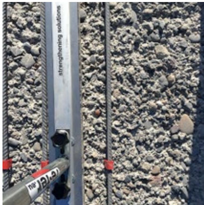
4 Activeren van de re-bar met Infraroodstraler re-IR 1500
