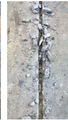
1 Het inbrengen van de groef in de betonnen ondergrond (breedte 3,5 cm / diepte 2,5 cm / voor re-bar Ø12 mm)
