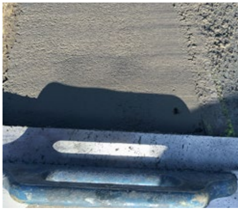
3A Inbedding aan beide zijden in Sika MonoTop 452 N «Herprofilermortel» als eindverankering
