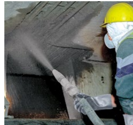
5B Sika MonoTop-422 PCC aanbrengen tussen de eindbevestigingen
