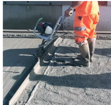
5A Sika MonoTop-452 N aanbrengen tussen de eindbevestigingen
