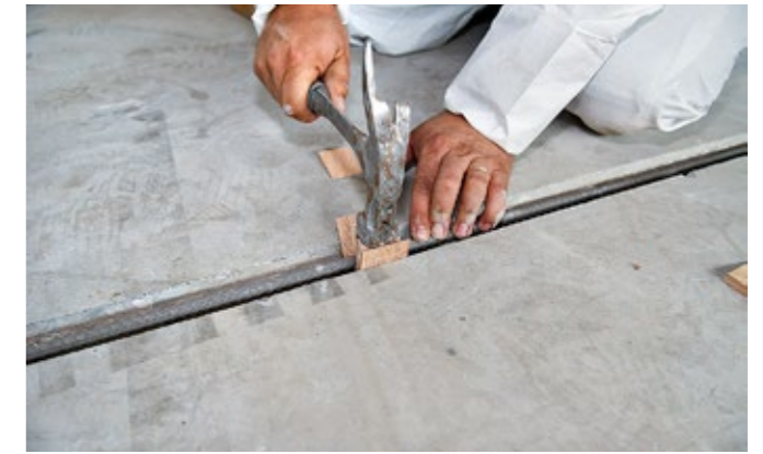
2 re-bar centraal vastzetten in betongroef
