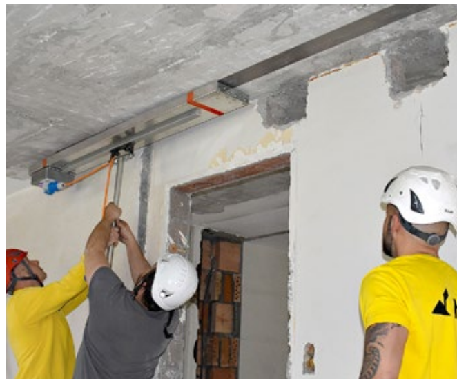
5 Stapsgewijze verwarming met re-IR 3000 infraroodverwarming
