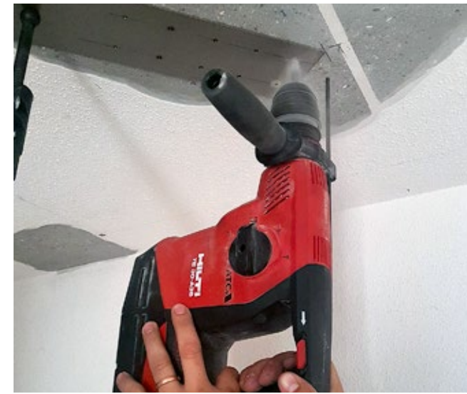
3 Ondergrond voorboren door voorgeperforeerde re-plate, boordiameter \varnothing 3,5 mm
