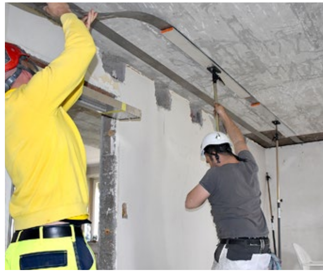
2 Bevestig de re-plate tijdelijk met T-steunen
