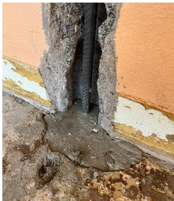
Mörtelverankerung von re-bar in der Betondecke
