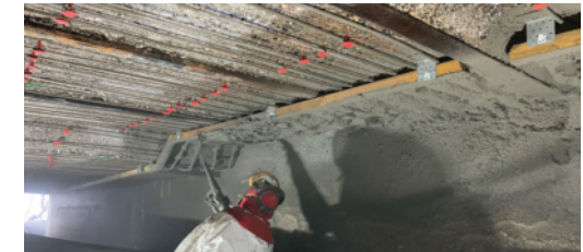
Renforcement en flexion d'un pont avec re-bar et Sika Monotop
