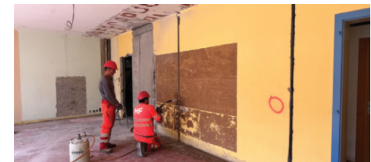
Renforcement sismique de murs en maçonnerie avec re-bar
