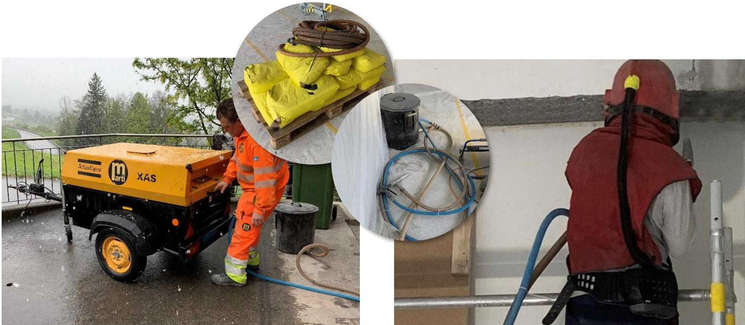
Kompressor, ca. 3-5 m<sup>3</sup> (hat Bauunternehmer), mobiles Strahlgerät und Strahlgut (hier: Korund)
