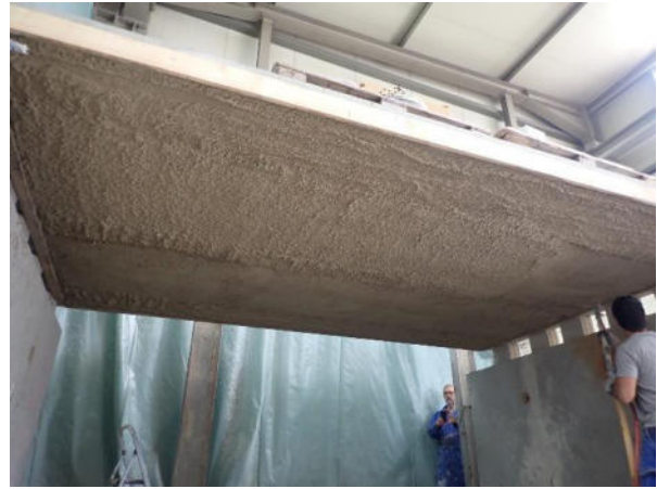
Bild A3.8 Aufbringen des Brandschutzputz
