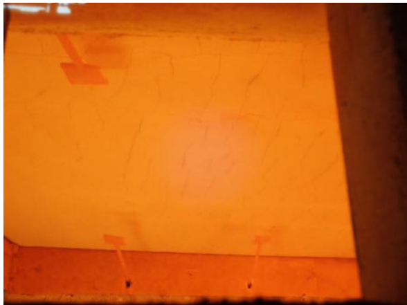
Bild A3.15 Rissbild (70. Prüfminute)
