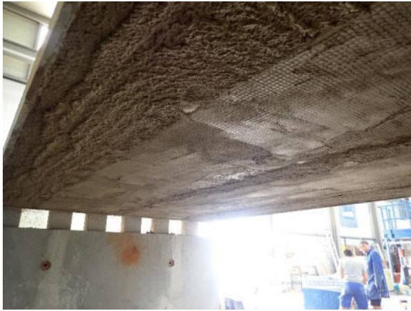
Bild A3.7 Einkleben des Glasgitters
