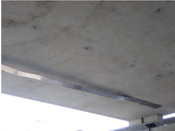
Bild A3.1 Befestigung der ersten Lamelle – Durchhang vor Aktivierung des Memoryeffektes
