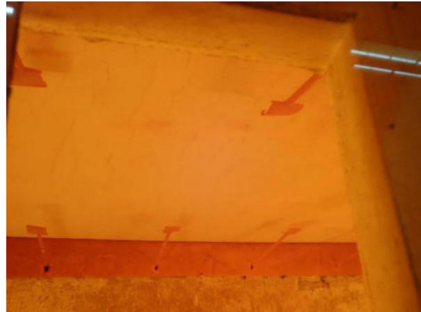
Bild A3.14 Rissbild (50. Prüfminute)
