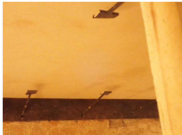
Bild A3.12 Blick in den Brandraum (1. Prüfminute)
