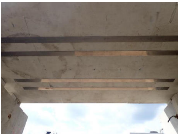
Bild A3.5 Abschluss der Installation der statischen Verstärkung
