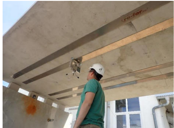
Bild A3.4 Prüfung der Vorspannung
