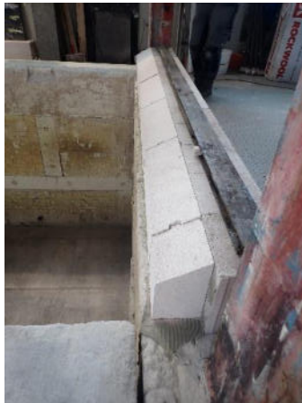
Bild A3.9 Ansicht des gelenkigen Auflagers vor dem Auflegen des Probekörpers
