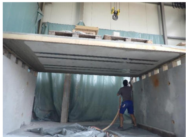
Bild A3.6 Aufspritzen des Haftvermittlers
