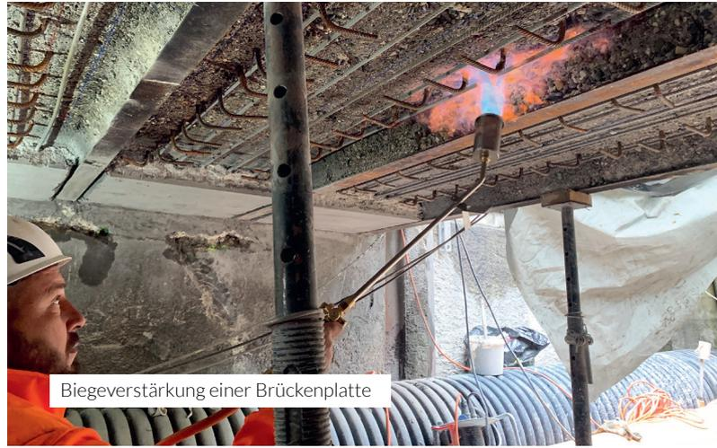
Biegeverstärkung einer Brückenplatte
