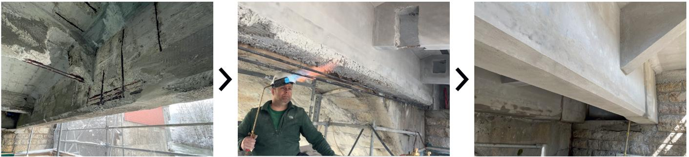
Dank der aktiven Vorspannung sind weniger Durchbiegungen und eine spätere Rissöffnung zu erwarten. Die Kräfteinleitung erfolgt in den gesunden Kernbeton des Bestandes. re-bar als robuste Biege- oder Schubverstärkung erhöht die Lebensdauer einer Tragstruktur. Die Stahlbewehrung im Bestand wird aktiv entlastet.
