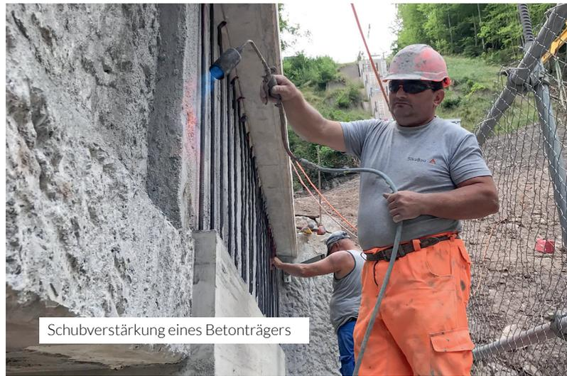
Schubverstärkung eines Betonträgers
