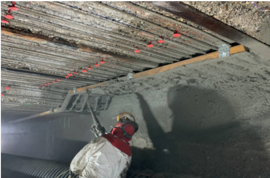
memory®-steel re-bar inséré dans Sika mortier de remplacement du béton
