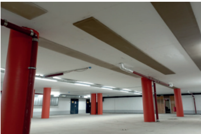
SikaCem® Pyrocoat seulement localement sur re-plate
