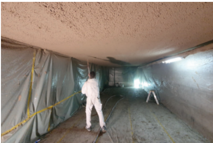
SikaCem® Pyrocoat sur toute la surface de renforcement
