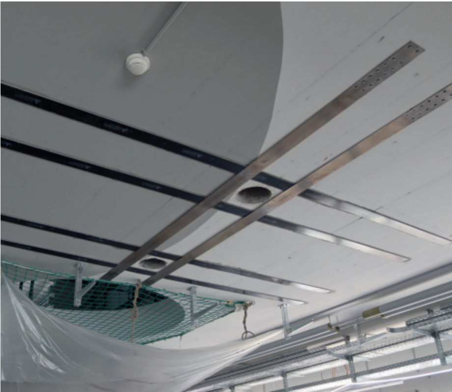
Combinaison de Sika® CarboDur® avec re-plate
