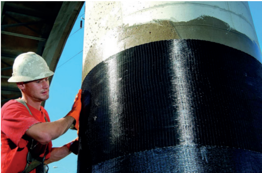
Confinement avec SikaWrap®
