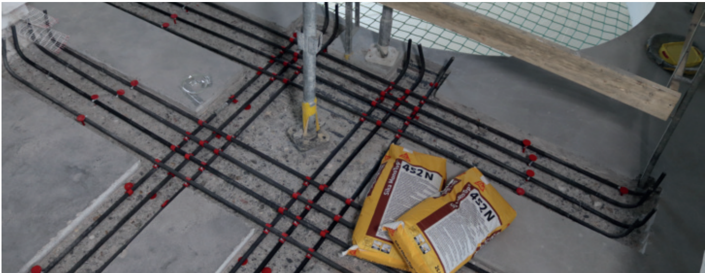
re-bar inséré dans Sika MonoTop® (Protection incendie grâce au recouvrement avec le mortier)
