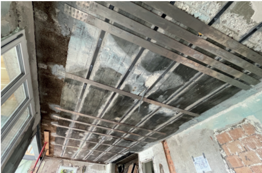
Combinaison de Sika® CarboDur® avec memory®-steel re-plate
