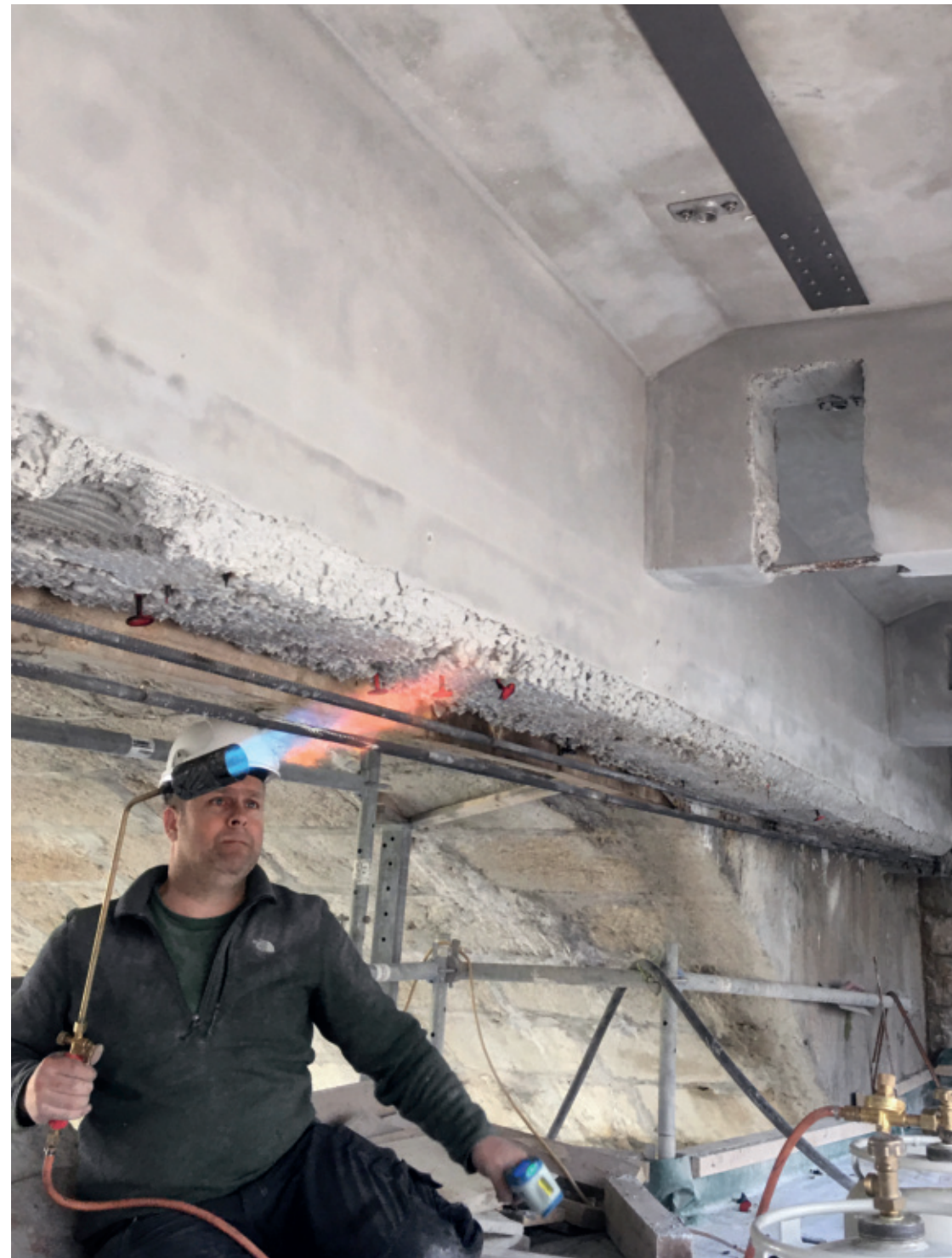
Enlèvement hydromécanique du béton endommagé et création d'une surface rugueuse
