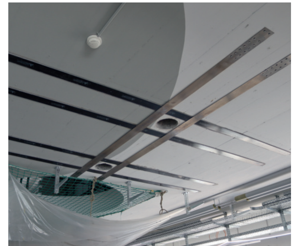
Kombination von Sika® CarboDur® mit re-plate
