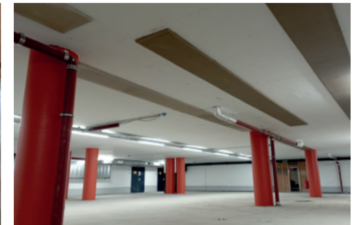
SikaCem® Pyrocoat nur lokal über re-plate
