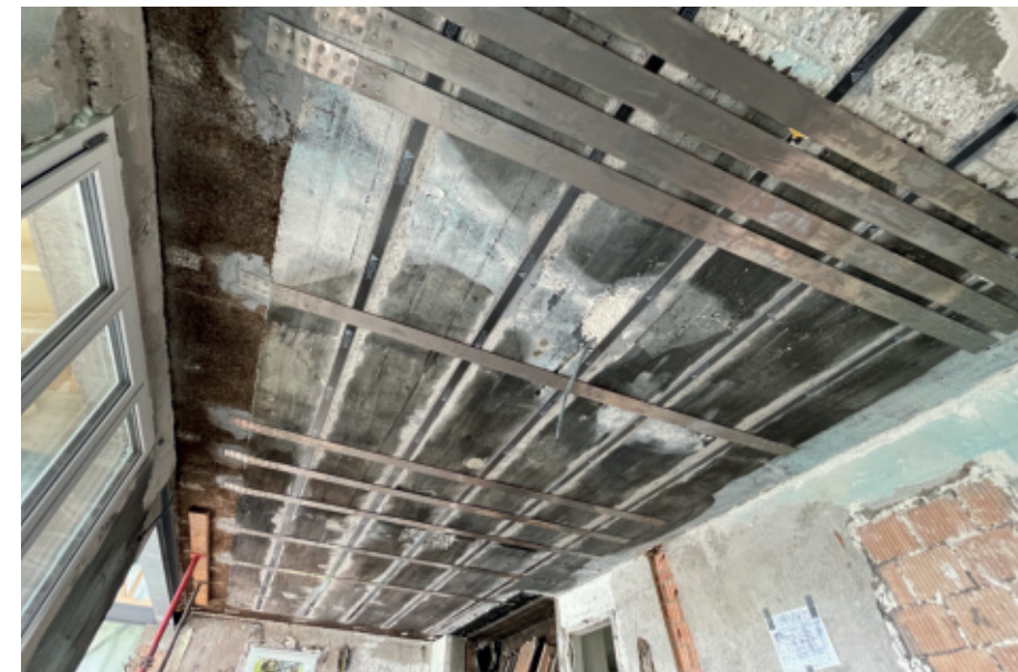
Kombination Sika® CarboDur® mit memory®-steel re-plate
