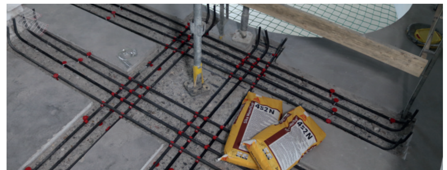
re-bar eingelegt im Sika MonoTop® (Brandschutz dank Mörtelüberdeckung)
