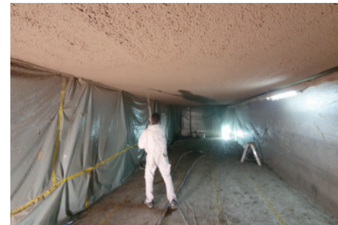
SikaCem® Pyrocoat über gesamte Verstärkungsmaassnahme
