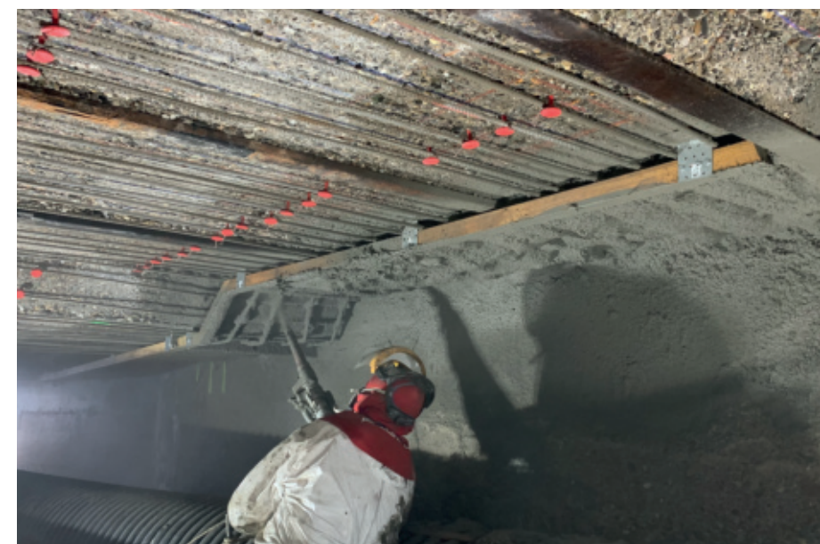
memory®-steel re-bar im Sika Betonersatzmörtel
